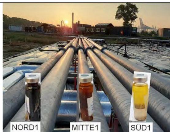
Tanklagersanierung mit dem TUBA-Verfahren (10.000m<sup>2</sup>) – Austrag: über 280 Tonnen in 17 Monaten (© *reconsite*)
