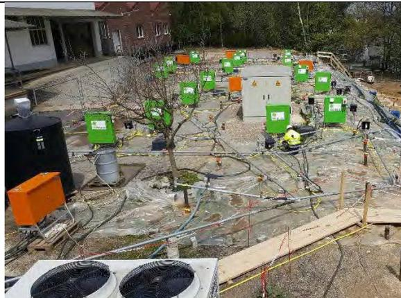
THERIS-Sanierung eines LHKW-BTEX-Schadens bis 20 m Tiefe (© reconsite)
