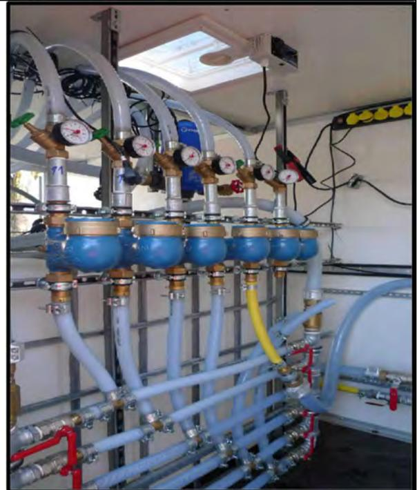
*Beispiel einer DNBA-Substratum & Nährstoffverteilungsanlage zur Grundwassersanierung (LHKW) (Quelle: F. KARG 2020)*
