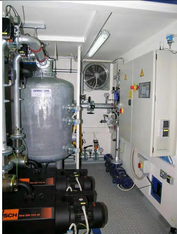
MPE-Anlage nach ATEX-Standard, eingebaut in 10'-Container (Quelle: M: Cornelsen, 2018)
