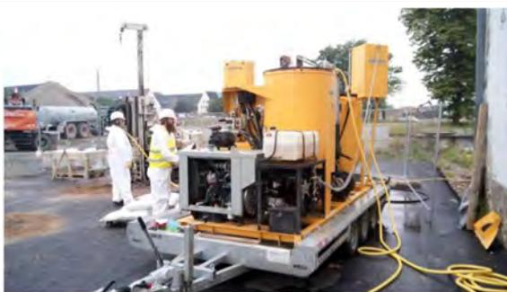
Verpressung von EHC Feststoff Reagenzien (Zellulose mit nullwertigem Eisen) im Schadensherd mittels TSE® Injektion
